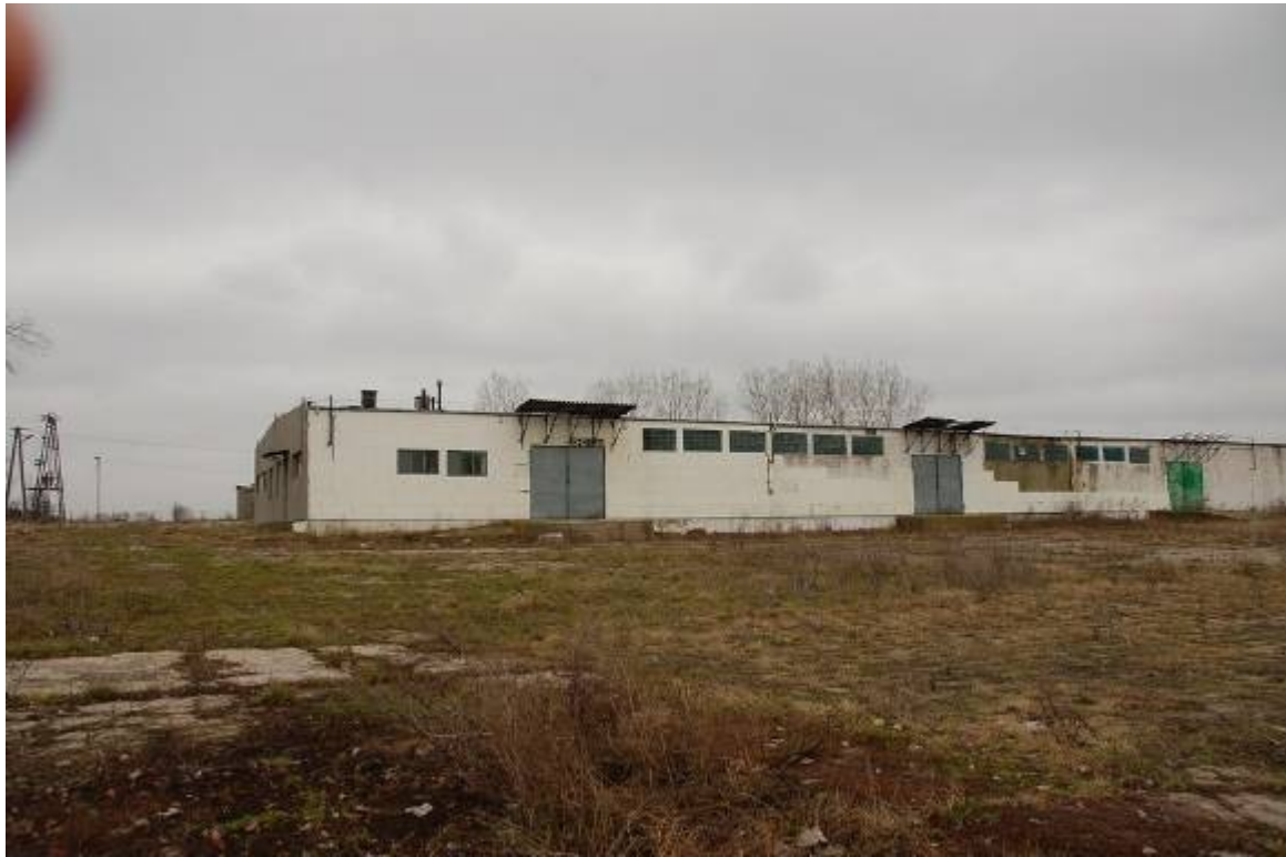
Rysunek 5 budynek magazynowy
