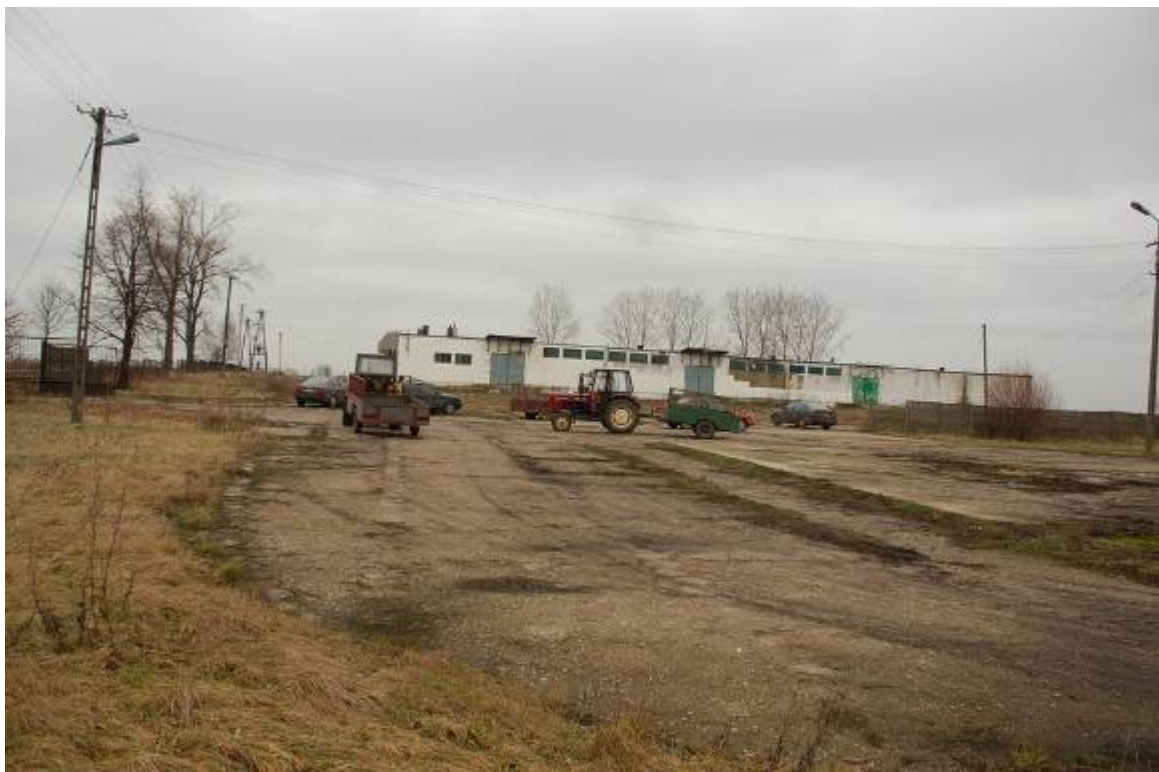
Rysunek 4 budynek magazynowy
