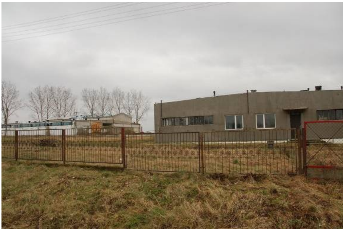
Rysunek 2 budynek po byłej mieszalni pasz
